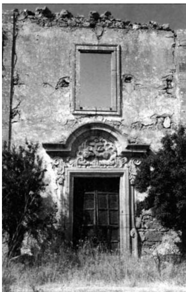
9. Salaparuta. Chiesa della Trinità e chiesa della Madonna della Lettera, facciata prima del terremoto (da B. Graffagnino, 1992).
