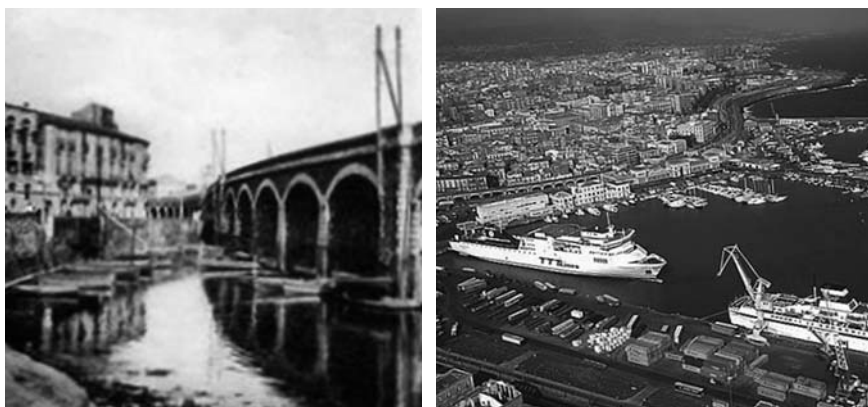
Foto 1. Il porto di Catania all’inizio del secolo XIX. Foto 2. Il porto di Catania oggi.
