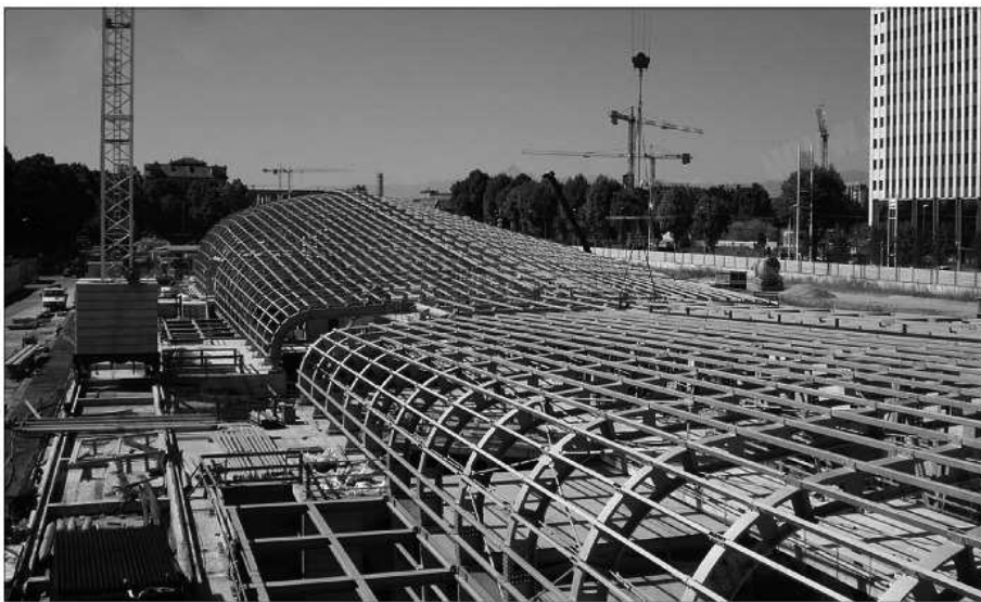
AREP con Silvio d'Ascia e Agostino Magnaghi, Stazione AV di Torino Porta Susa, vista della galleria vetrata in costruzione, 2010.
