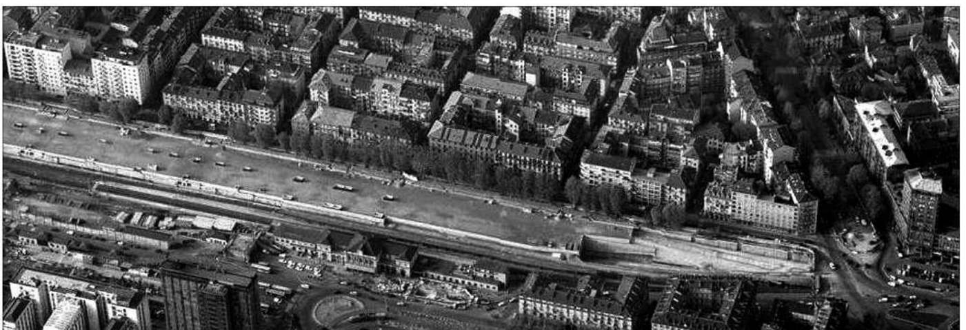
AREP con Silvio d'Ascia e Agostino Magnaghi, Stazione AV di Torino Porta Susa, vista aerea del cantiere (2010); a destra lo scavo per la piazza d'uscita della metropolitana.
