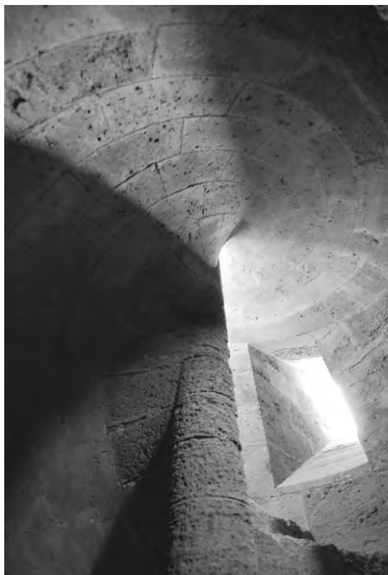
Fig. 2 - Siracusa. Castello Maniace, scala del tipo vis de Saint Gilles nella torre est (foto di M. M. Bares).
