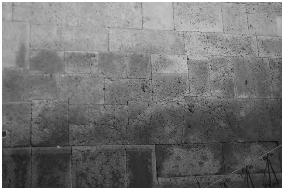
Fig. 7 - Randazzo. Chiesa di Santa Maria, particolare del paramento in pietra lavica sul fianco meridionale (foto dell'autrice).
