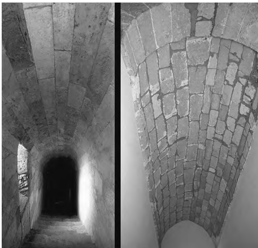
Fig. 3 - Siracusa, Castello Maniace, volta a botte inclinata sulla scala che conduce al “bagno della regina” (sinistra) (da M. M. Bares, Il castello Maniace cit., Siracusa 2011); Palermo, Palazzo Chiaromonte, volta a botte inclinata a copertura della scala (destra) (foto dell'autrice).
