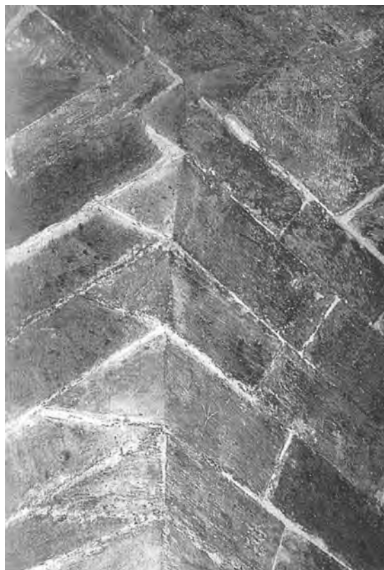
Fig. 1 - Catania. Castello Ursino, particolare dell'incastro dei conci angolari di una volta (da M. M. Bares, Il castello Maniace cit., Siracusa 2011).
