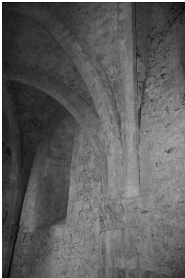
Fig. 5 - Mussomeli. Castello, particolare dell'imposta delle volte della cappella (foto dell'autrice).
