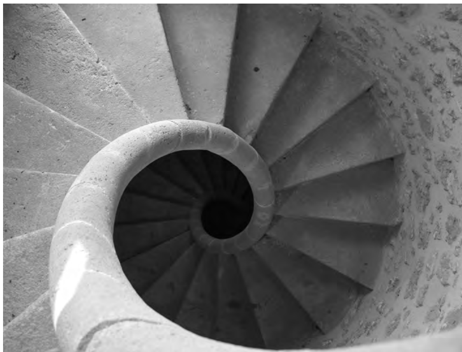
Fig. 4 - Castellammare del Golfo. Castello, scala a chiocciola del tipo caracol de Mallorca (foto di M. R. Nobile).
