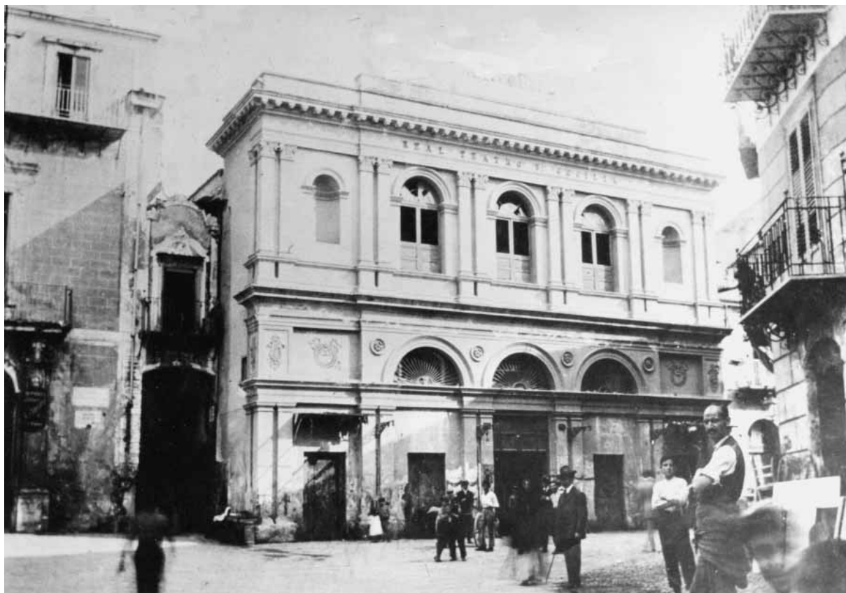
130. Prospetto del Teatro Santa Cecilia riconfigurato, nel 1854, su progetto di Giuseppe Di Bartolo. A sinistra, scorcio del palazzo Sarzana, marchesi di Sant'Ippolito, demolito negli anni Trenta per la realizzazione di via Cantavespri. Si nota, tra il palazzo e il teatro, l'ingresso al vicolo del Forno alla Fieravecchia. Inizi del XX secolo.
