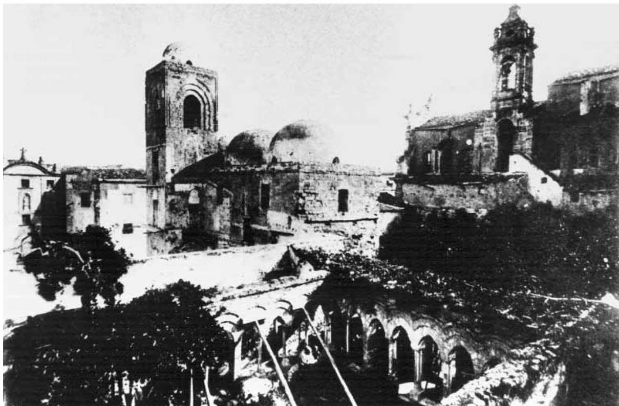
163. Il chiostro di San Giovanni degli Eremiti in seguito agli interventi di Giuseppe Patricolo. Fine del XIX secolo.
