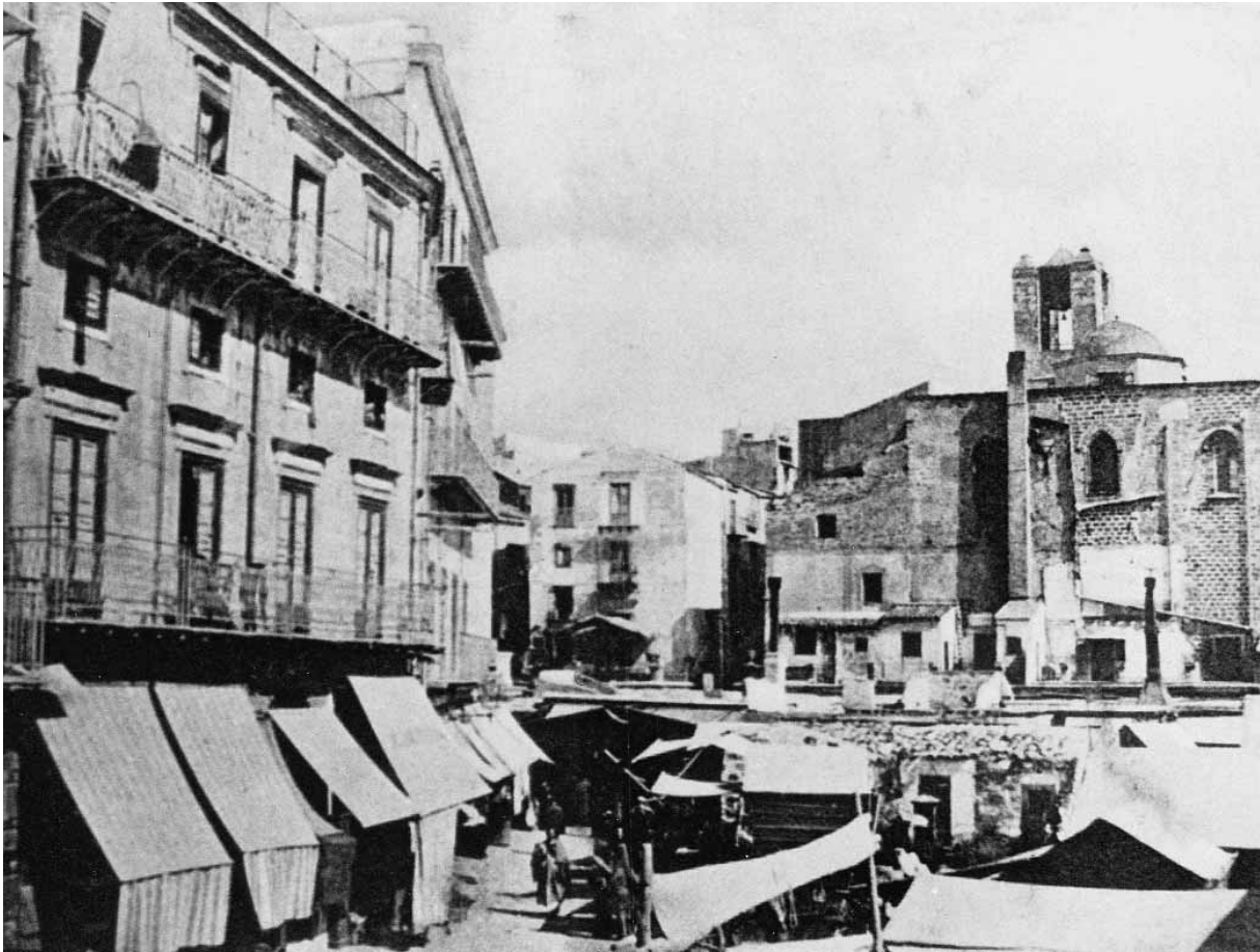
27. Discesa dei Maccheronai e piazza Caracciolo durante i lavori di demolizione per la costruzione di via Roma. In fondo è il prospetto laterale della chiesa di Sant'Antonio Abate. Fotografia scattata tra il 1895 e il 1898 [Ed. Devaux, Paris].
