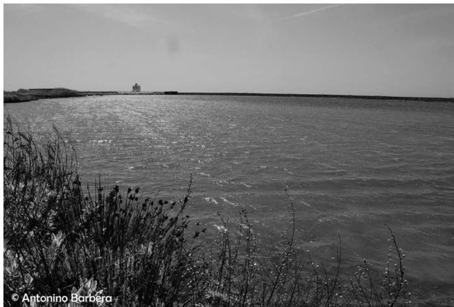
Fig. 1 — Laguna di Tonnarella. Veduta con sfondo della diga foranea (Foto: A. Barbera).
