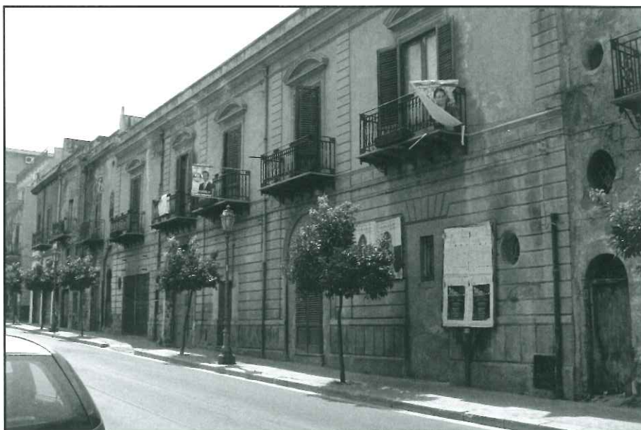
Fig. 1. Bagheria, corso Butera, palazzo Dragotta. L'edificio è un esempio rilevante di architettura, del sec. XIX, che merita di essere tutelato, restaurato e anche riutilizzato con funzioni compatibili.
