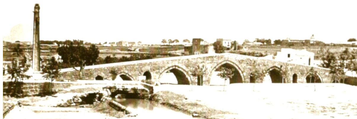
Figura 6: Negli ultimi decenni del secolo XIX il ponticello si presentava in condizioni di degrado e, probabilmente, leggermente allargato.
