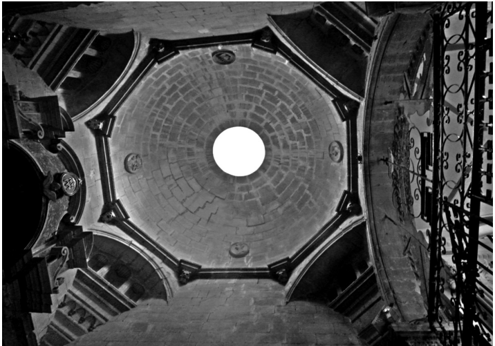
Modica. Chiesa di Santa Maria di Betlem, navata centrale e cappella dei Confrati, dettaglio della cupola.
