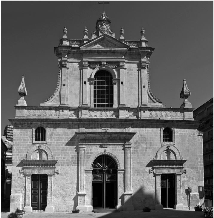
Modica. Chiesa di Santa Maria di Betlem, prospetto.
