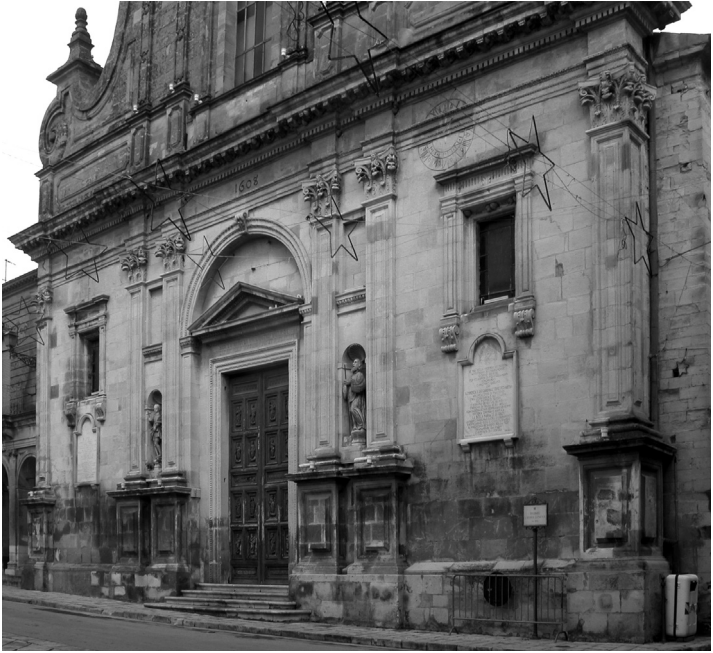
Chiamonte Gulfi. Chiesa Madre, particolare del prospetto.
