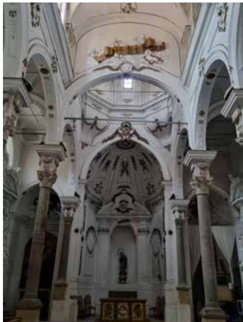
◇ Fig. 11 – Palermo. Church of San Giovanni dei Napoletani, interior view with columns made of Termini stone (photograph by L. Barrale). Palermo. Chiesa di San Giovanni dei Napoletani, veduta interna con le colonne in pietra di Termini (fotografia di L. Barrale).
