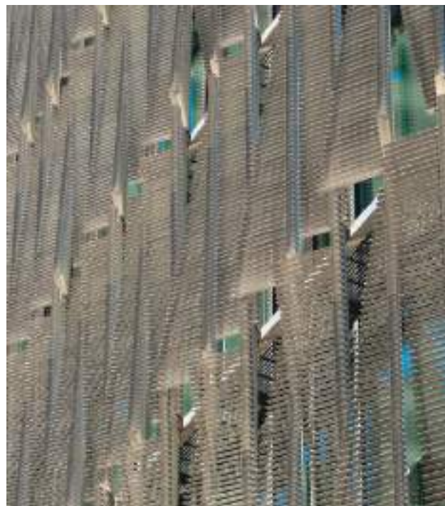
Fig. 1 | Q1 – Thyssenkrupp Quartier, JSWD Architekten, 2010, Essen Germany (credits: www.jswd-architekten.de/projekte/thyssenkrupp-quartier/ ).
