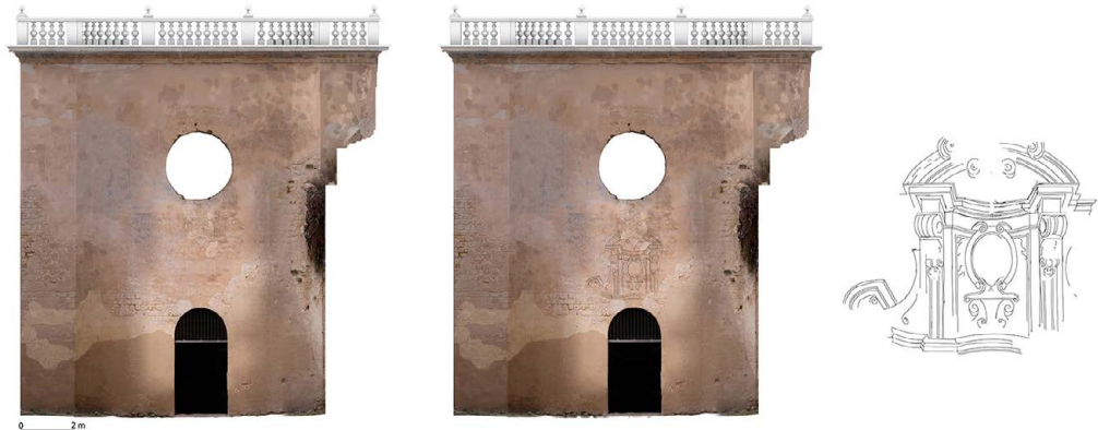
Fig. 7. A sinistra: ortofoto della facciata della chiesa di Santa Maria della Grotta a Marsala. Al centro: evidenziazione del disegno inciso sull'intonaco. A destra: rimarcatura dei tratti superstiti del disegno prospettico del portale. Elaborazione di M. Cannella).
