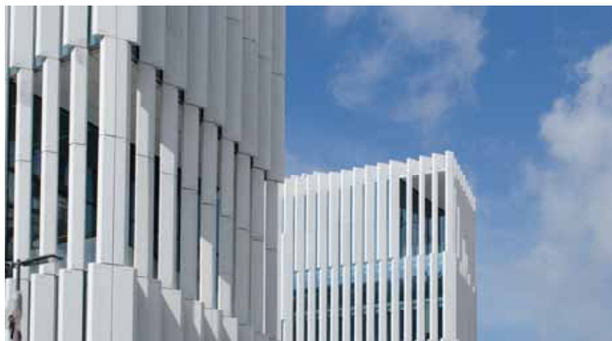
Figura 4 – Aires Mateus Associados, la struttura/frangisole della sede EDP a Lisbona.
