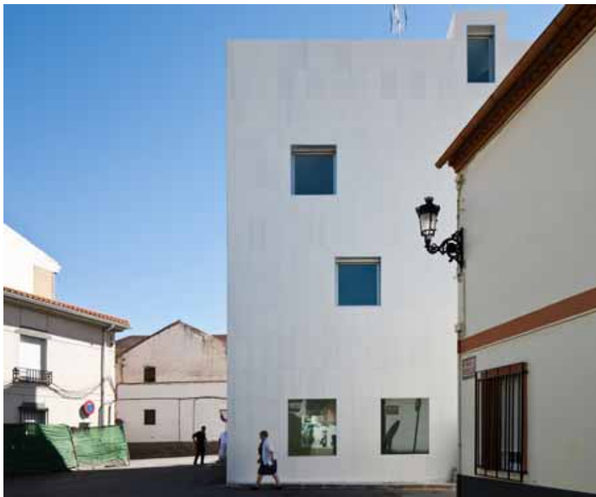
Figura 3 – Elisa Valero Ramos, involucro ceramico innovativo dell’edificio residenziale a Gojár.
