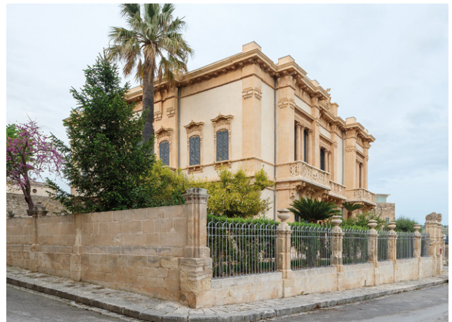
Fig. 4. Ragusa Ibla, il villino Arezzo dopo il restauro delle sue facciate (foto F. Poli 2023).
