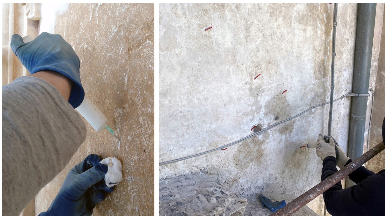
Figg. 5a-5b. Ragusa, il palazzo Florida Bertini (a sinistra) e Ragusa Ibla, il villino Arezzo (a destra), cantieri di restauro, interventi di riadesione degli intonaci mediante iniezioni consolidanti (foto G. Gatto 2018-2022).
