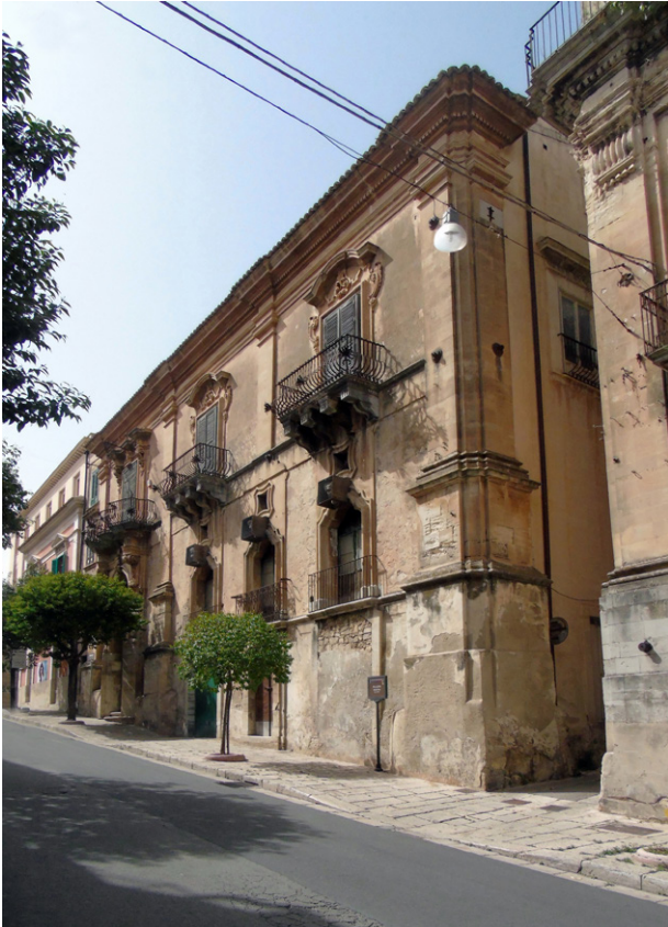
Fig. 1. Ragusa, palazzo Florida Bertini. La facciata principale del palazzo prima del restauro (foto G. Gatto 2017).
