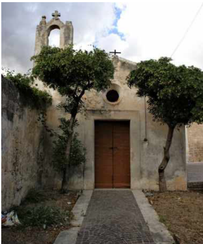
Figura 2. Il prospetto della "chiesetta vecchia", prima del crollo della copertura (2014).
