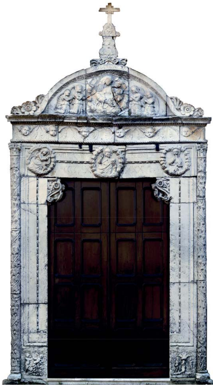
Ortofotopiano del portale di Santa Maria la Porta prima del restauro.
