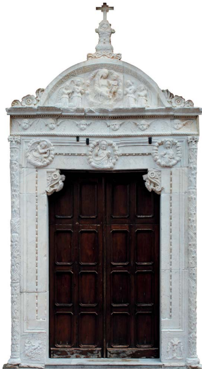
Ortofotopiano del portale di Santa Maria la Porta dopo il restauro.
