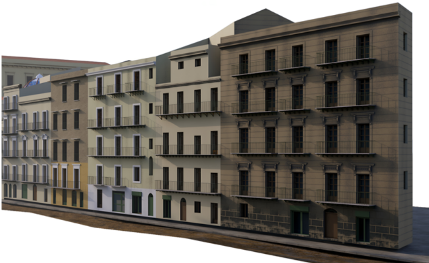
Cortina edilizia fronte sud
