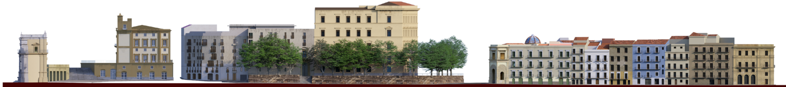
Profilo stradale sud-est di Corso Vittorio Emanuele a Palermo
