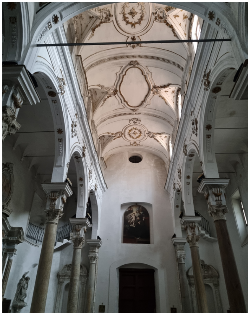
Fig. 2 Vista della navata centrale verso la parete d'ingresso principale
