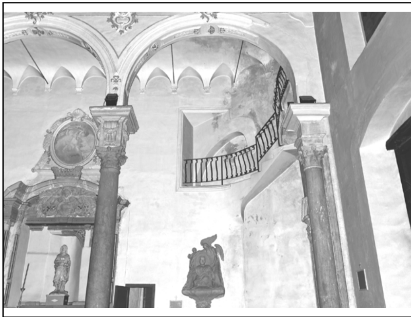
Fig. 15 Vista delle scale dalla navata. Risulta chiara la morfologia contorta della scala, che "sbucca" dal muro e si ritorce per assestarsi in prossimità del piano superiore.
