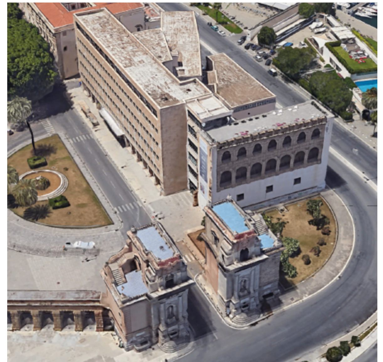
Fig. 10 Vista aerea del complesso dell'Istituto Nautico (IIS Gioeni Trabia) di Palermo con in testata il blocco dei locali espositivi che inglobano i resti dell'antico loggiato. Fonte Google Earth.
