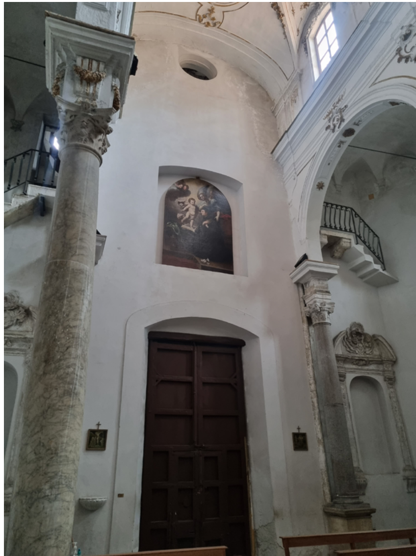
Fig. 6 Vista del portale d'ingresso principale e delle edicole laterali; in asse con il portone, posto in alto, la nicchia del letterino.
