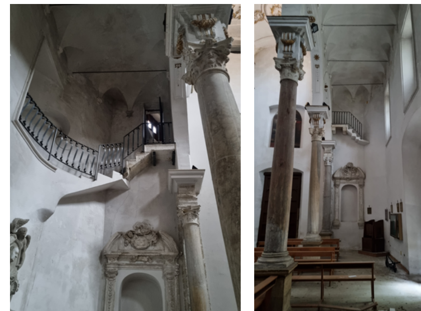
Fig. 10 Vista interna delle scale d'accesso agli ambienti superiori
