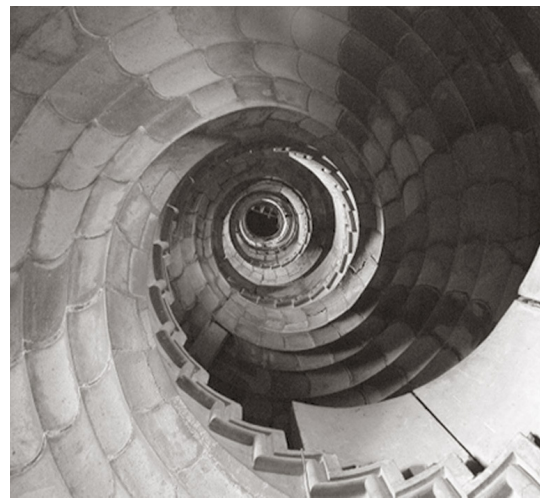
1.10 Napoli, scala maggiore a caracol de Mallorca (foto Maria Mercedes Bares). Il vuoto centrale si presta al sollevamento di materiali e di pali per le centine.
