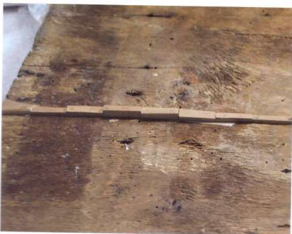
Fig. 11. Fase di risanamento del supporto con i cunei in pioppo.
