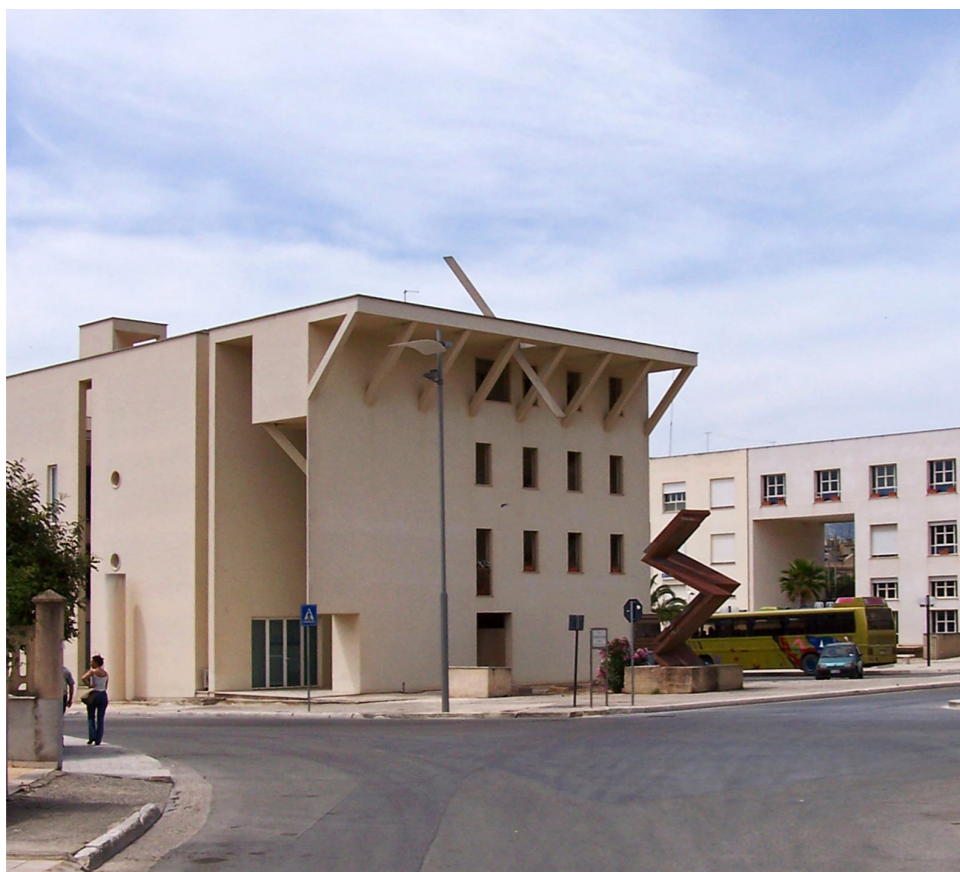
3 F. Purini e L. Thermes, Casa Pirrello (Gibellina Nuova), 1990, foto di A. Margagliotta
