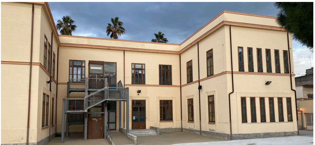
Fig. 42 - Vista del lato interno della Scuola F. Orestano
