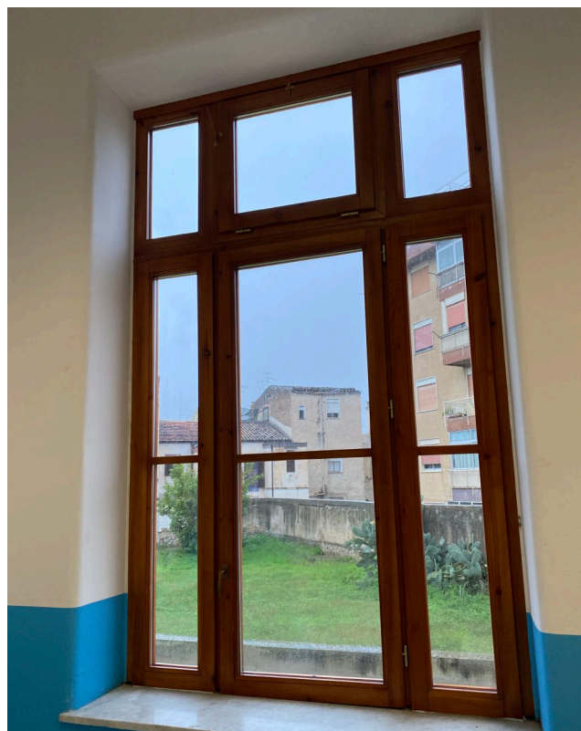
Fig. 5.3 - Il nuovo infisso a seguito dell'intervento di sostituzione del maggio 2021 (F.R. 25/11/2021)
