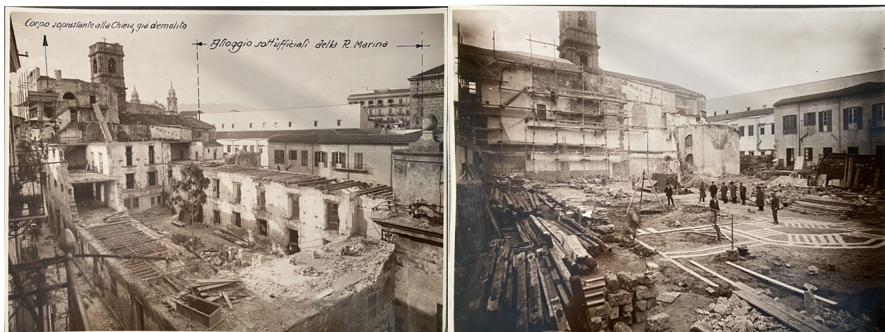
Figg. 10 e 11 - (a sinistra) Lavori di demolizione del monastero di S. Maria in Valverde e (a destra) inizio dei lavori di costruzione del nuovo edificio scolastico di via Valverde (oggi "Rita Atria") [Archivio Storico di Palermo, Fondo L.L. P.P., Serie (2-3-1), 1936, Vol. 2]
