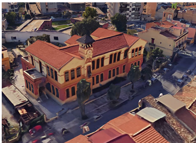
Fig. 22 - Scuola della borgata di Settecannoli, oggi F. S. Cavallari, costruita nel 1904-1907 su progetto dell'Ing. Nicolò Mineo (Immagine da GoogleEarth 2021)
