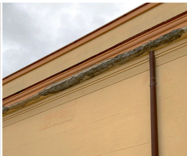
Fig. 43.4 - Gli esiti dell'intervento di messa in sicurezza. (Foto F.R. 04/12/2020)
