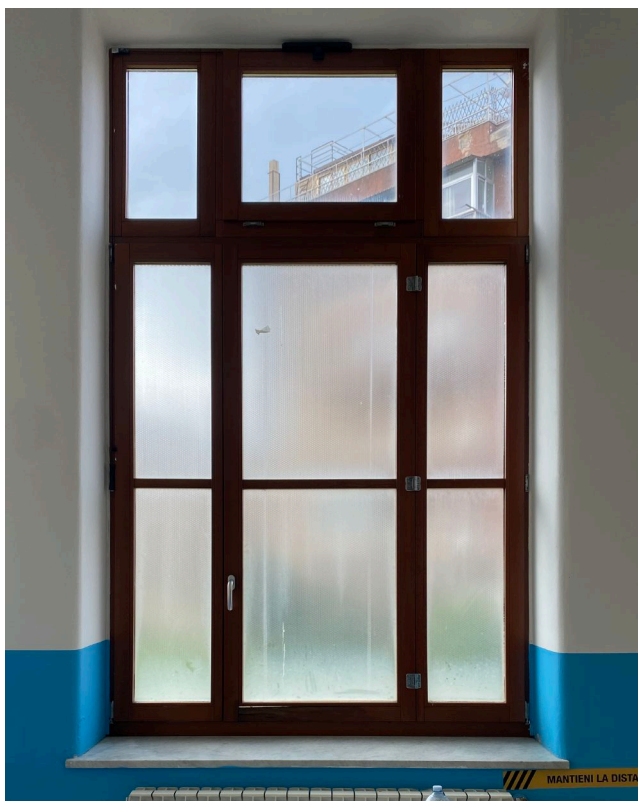
Fig. 5.1 - Finestra della Scuola "Conte Federico", infisso installato nel 2011 (F.R. 09/03/2021)
