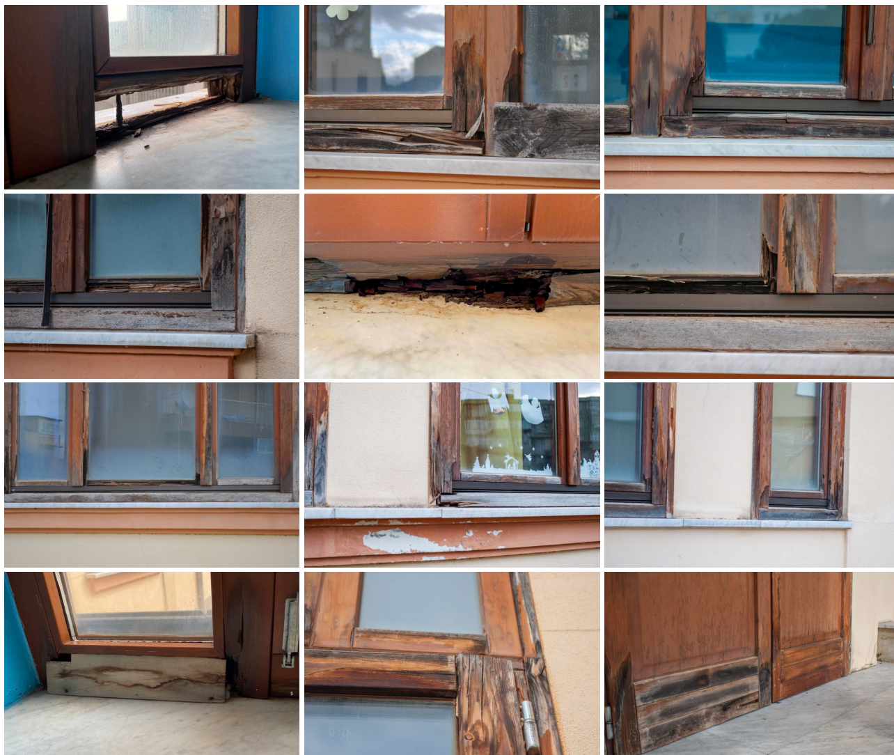
Fig. 48 - Alcuni dei degradi degli infissi esterni rilevati nella scuola F. Orestano
