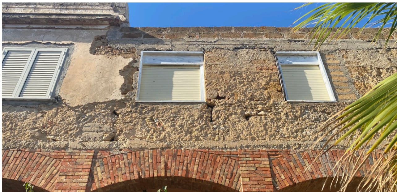
Fig. 8 - Interventi di manutenzione, dalla rimozione dell'intonaco alla sostituzione degli infissi e modifica delle aperture, condotti su uno degli edifici prospicienti la piazza del Borgo di fondazione di epoca fascista "A. Bonsignore" (Ribera, AG). (Foto F.R. 2021)
