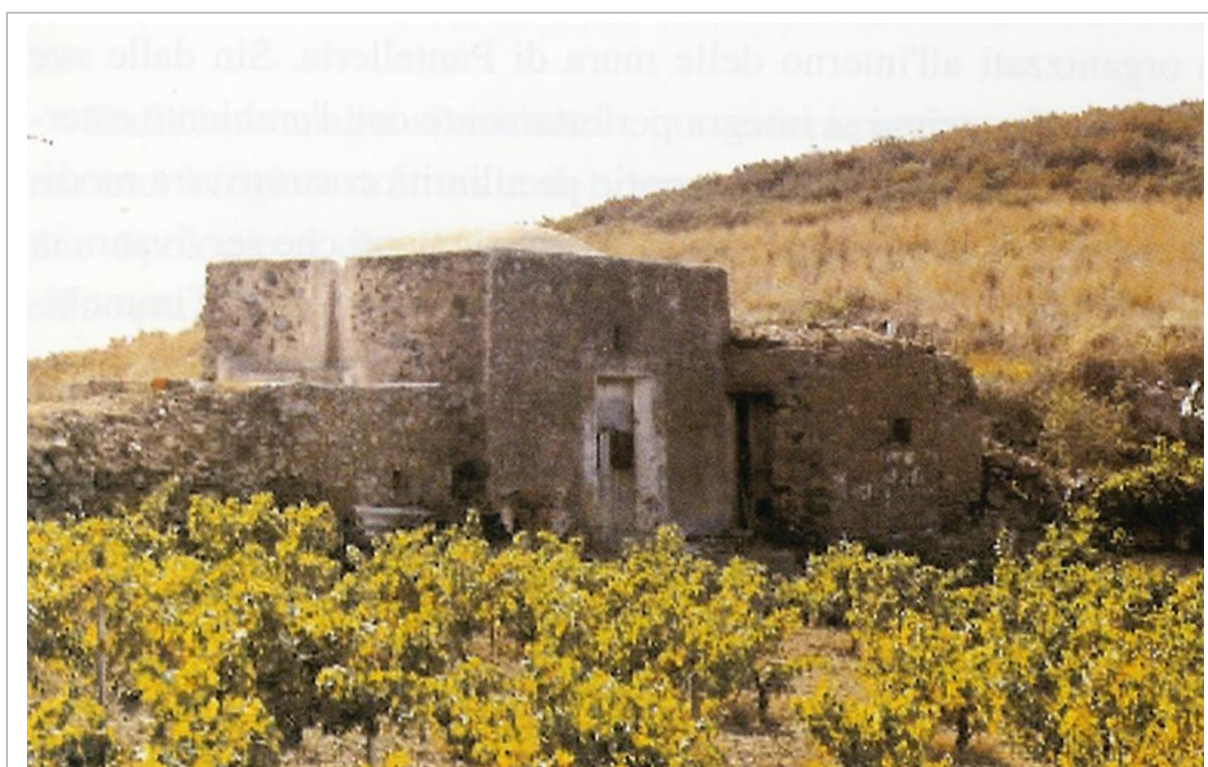
Figura 5: Pantelleria, Dammuso dalla copertura a "schiena d'asino" che convoglia l'acqua piovana nella cisterna mediante un incavo ricavato nella parete esterna (canallata).
