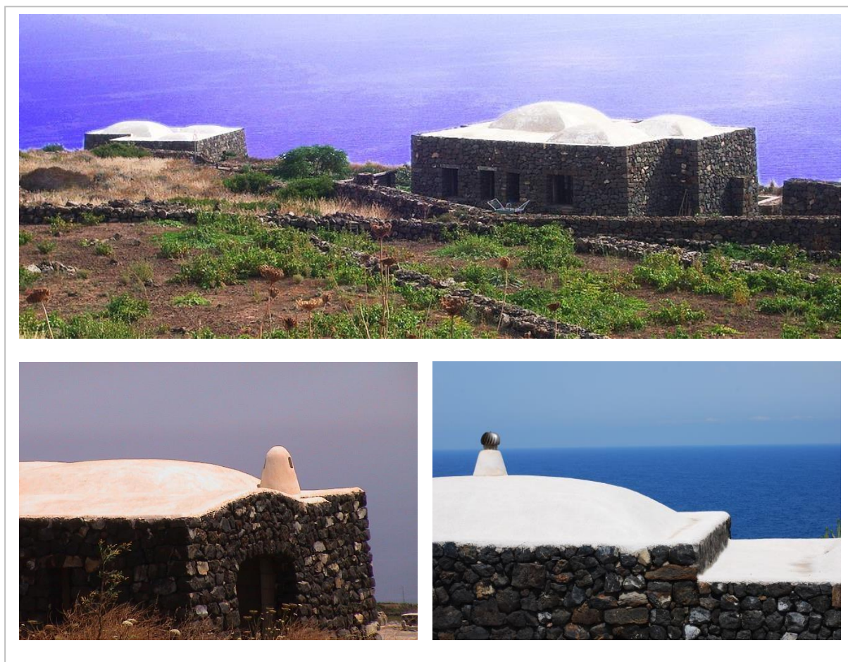
Figura 2: Isola di Pantelleria, paesaggio con i caratteristici Dammusi dalla copertura a "schiena d'asino" che convoglia l'acqua piovana nella cisterna mediante un incavo ricavato nella parete esterna.
