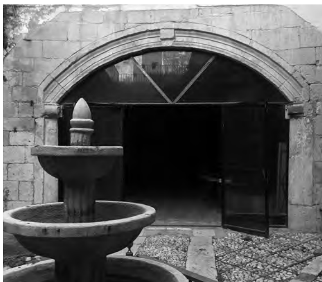
Fig. 7. Arco escarzano de la casa de los Peris.
