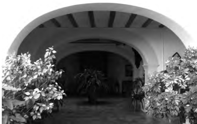
Fig. 8. Arcos apainelados de la casa Llácer.
