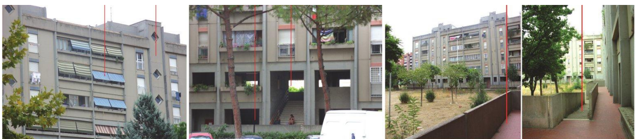
1- Borgata di Santa Maria del Soccorso, Roma (insediamento IACP del 1975), dettagli di alcuni edifici con il piano terra vuoto e la corte interna inutilizzata
