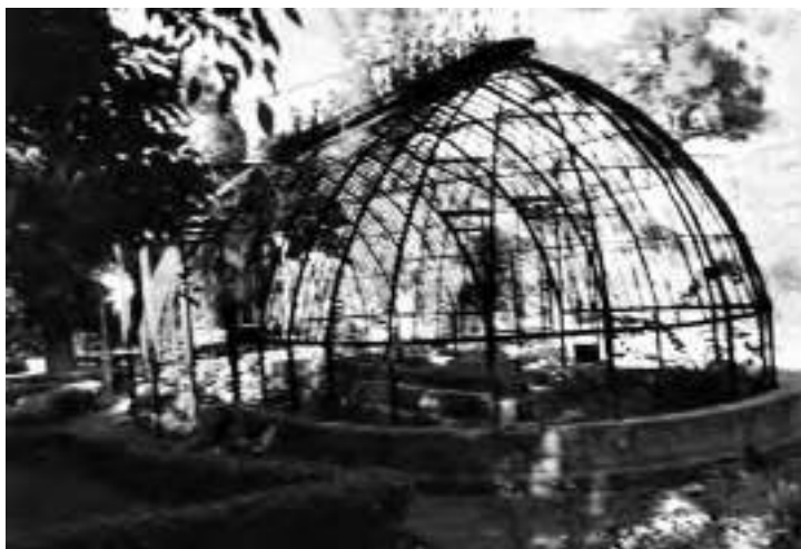
Fig. 65. G.B.F. Basile, 1850-1851, Giardino Inglese a Palermo, la serra prima dei restauri della fine del XX secolo (E. Mauro)
