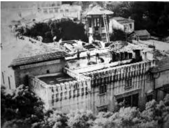
Fig. 36. Inizio della demolizione di Villa Lanza di Deliella eseguita il 28 novembre 1959
