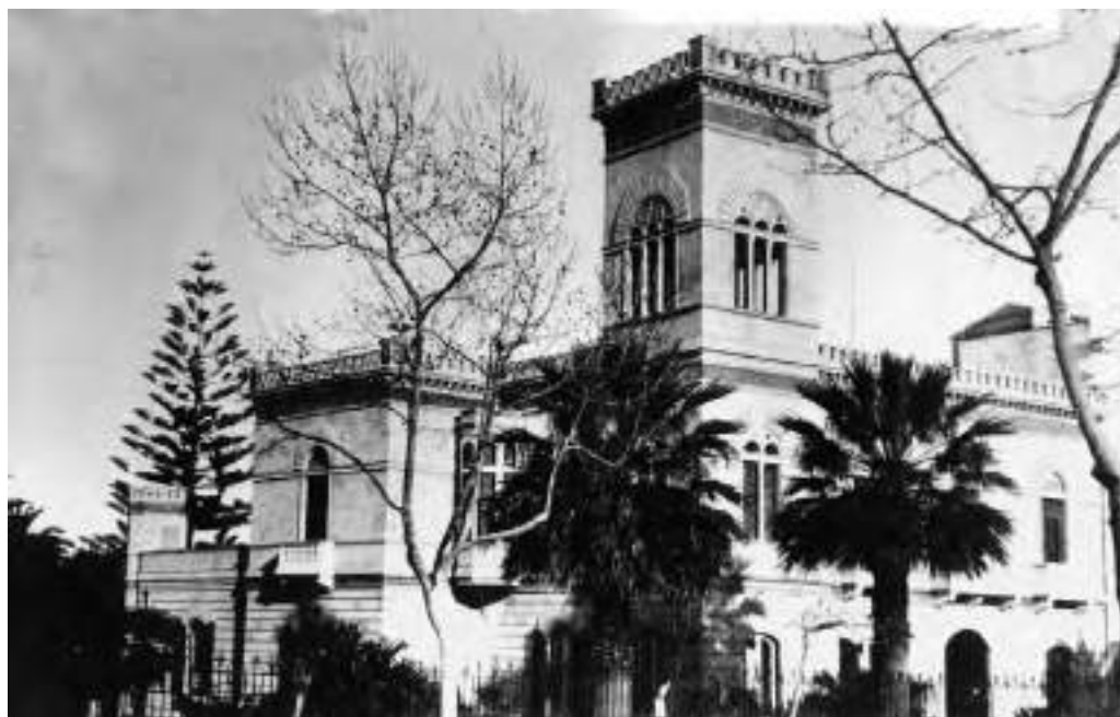
Fig. 30. Villa Tagliavia in via Libertà realizzata nel 1910 su progetto dell'architetto Ernesto Armò riconfigurando una preesistente "casina" costruita intorno al 1860. Foto inizi del XX secolo
