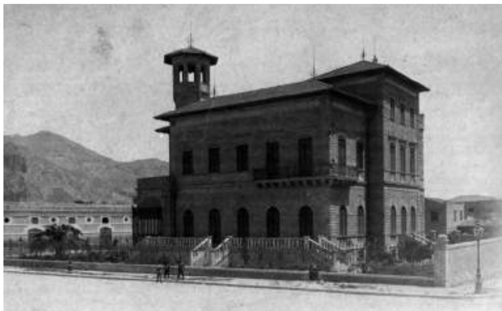
Fig. 33. E. Basile, Villa Deliella in piazza F. Crispi a Palermo, 1905-1908, veduta d'insieme del fronte sulla via A. Borrelli e del fronte piano delle Croci (poi piazza F. Crispi) con sullo sfondo a sinistra la via delle Croci e il prospetto principale della fabbrica di mobili Mucoli di F. La Porta e sulla destra uno dei due corpi di fabbrica delle scuderie di Villa Deliella (Foto Interguglielmi, coll. privata, Palermo)
