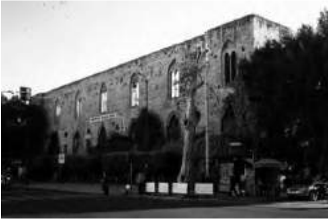
Fig. 41. G.B.F. Basile, 1850-1853, con C. Giachery e A. Gigante jr, 1853, prospetto sulla via della Libertà del Conservatorio delle Croci, fotografia 2005 (E. Mauro)
