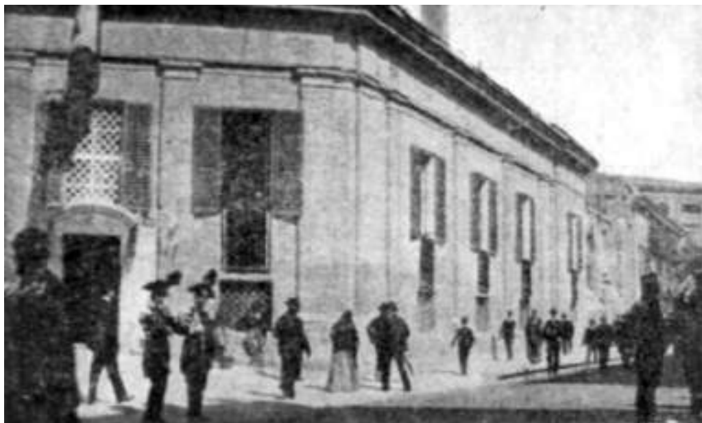
Fig. 9. Piazza marchese di Regalmici («Quattro Canti di Campagna»), 1902. Primo piano dell'incompleto palazzo Notarbartolo, duchi di Villarosa, costruito nel 1788 su progetto di Giuseppe Venanzio Marvuglia [Ed. Guarneri, Palermo]
