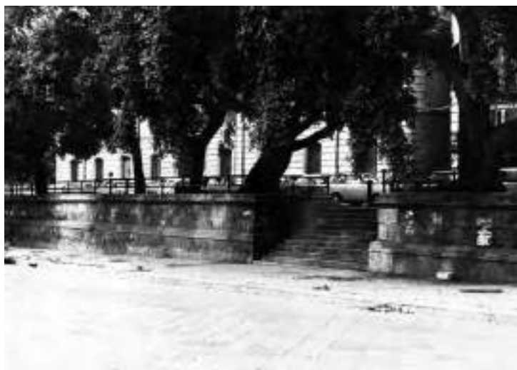
Fig. 79. G.B.F. Basile, 1861-1863, sistemazione urbana di Piazza Marina a Palermo , stilobate in pietra per il raccordo altimetrico tra la piazza e il piano di sedime degli edifici intorno; fotografia (da G. Pirrone, Palermo e il suo verde , in «Quaderno n. 5/6/7», 1965, Istituto di Elementi di Architettura, Palermo)
