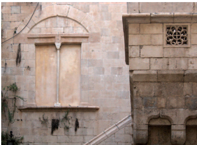
Fig. 2. Siracusa. Palazzo della Banca d'Italia, la scala scoperta e la finestra architravata della corte.
