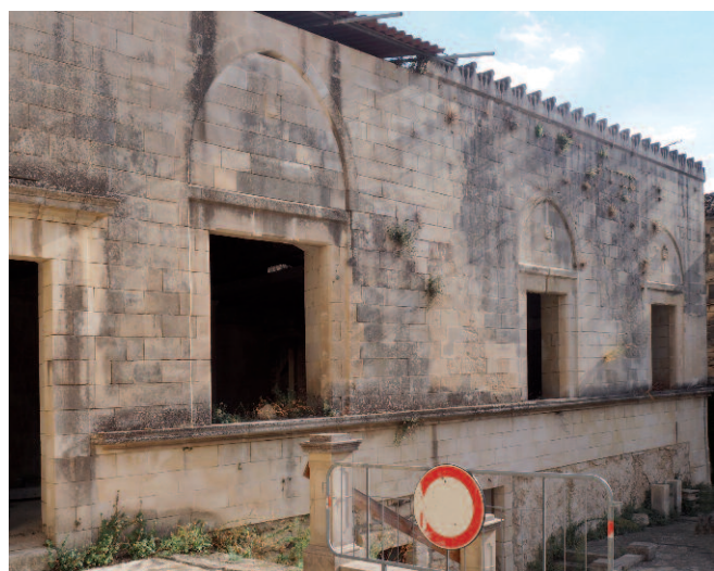
Fig. 13. Scicli. Palazzo Ribera, prospetto sulla corte.
