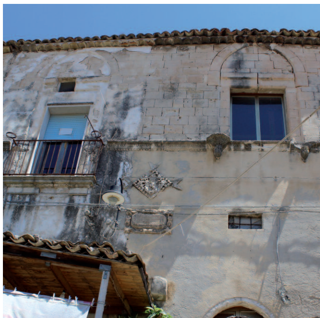
Fig. 12. Scicli. Palazzo Terranova Cannariati, facciata principale.
