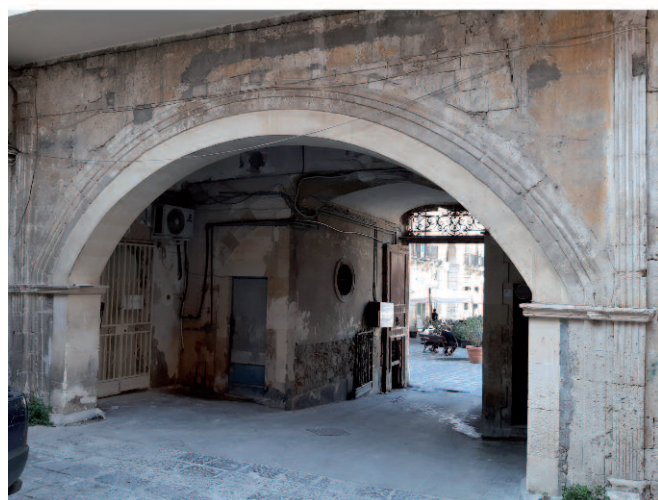
Fig. 8. Siracusa. Palazzo Lanza-Platamone, facciata e arco sulla corte.
