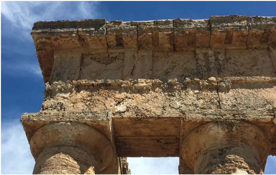
Fig. 12. Segesta. Grande Tempio. Articolazione dei conci della cornice. Spigolo sud-occidentale (foto dell'A.).
