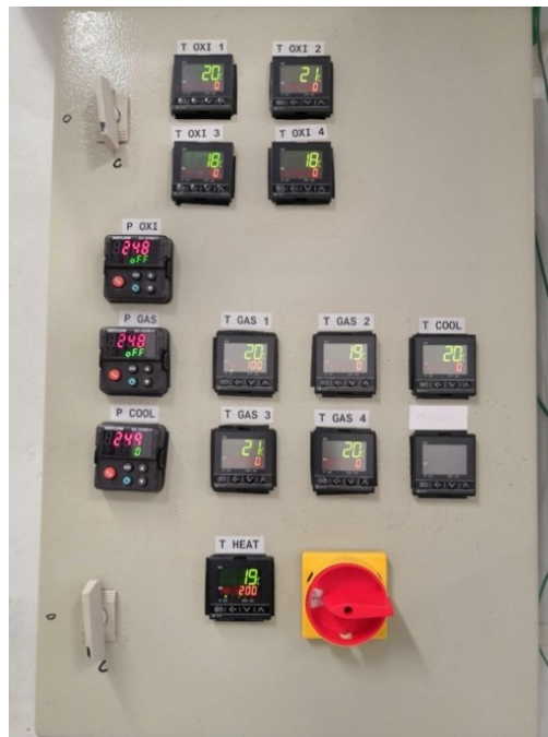
Figura 95 Valori di temperatura dopo 6 ore dall'inizio della prova di tenuta alla pressione di 250 bar
