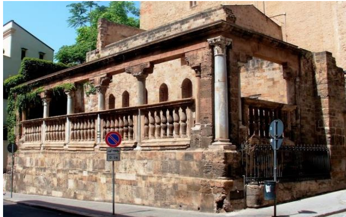
Loggia dell'Incoronazione, Cappella dell'Incoronata, Palermo.
