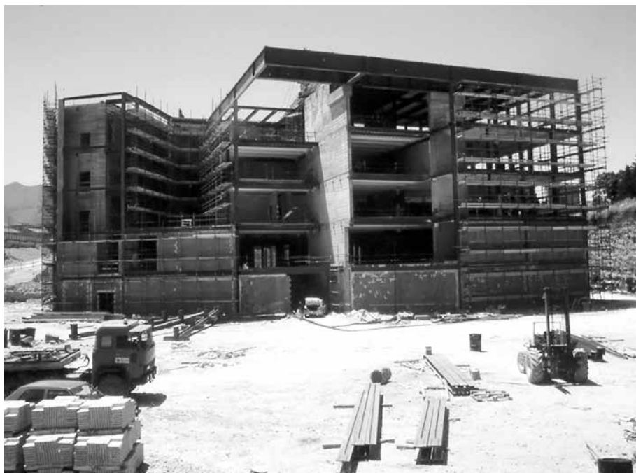
Pasquale Culotta, Edificio per la Facoltà di Architettura, Palermo 1992-1996, cantiere del 1° e 2° stralcio a strutture ultimate
