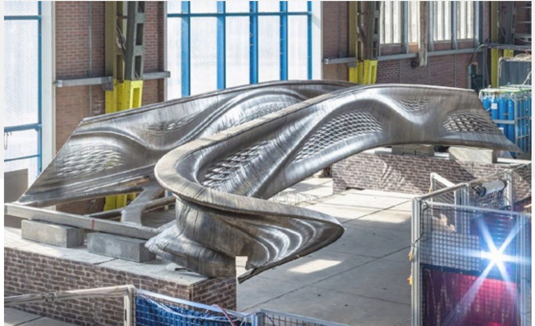
Figura 2.5.9: Il ponte in metallo interamente stampato in 3D dall'azienda MX3D. (foto MX3D)
