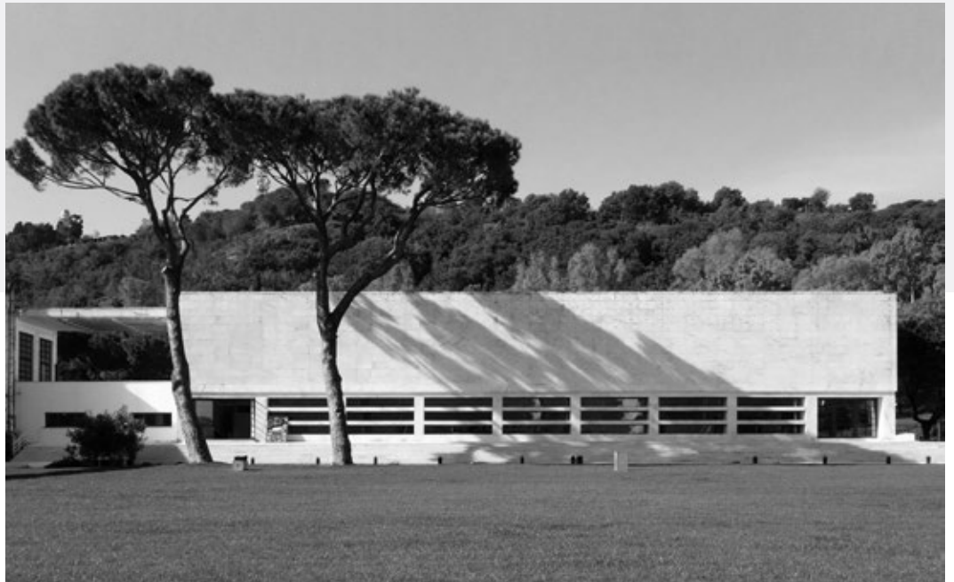
Figura 2.2.1.3: Il prospetto esterno dell'architettura. (foto Augusto Lisi)
