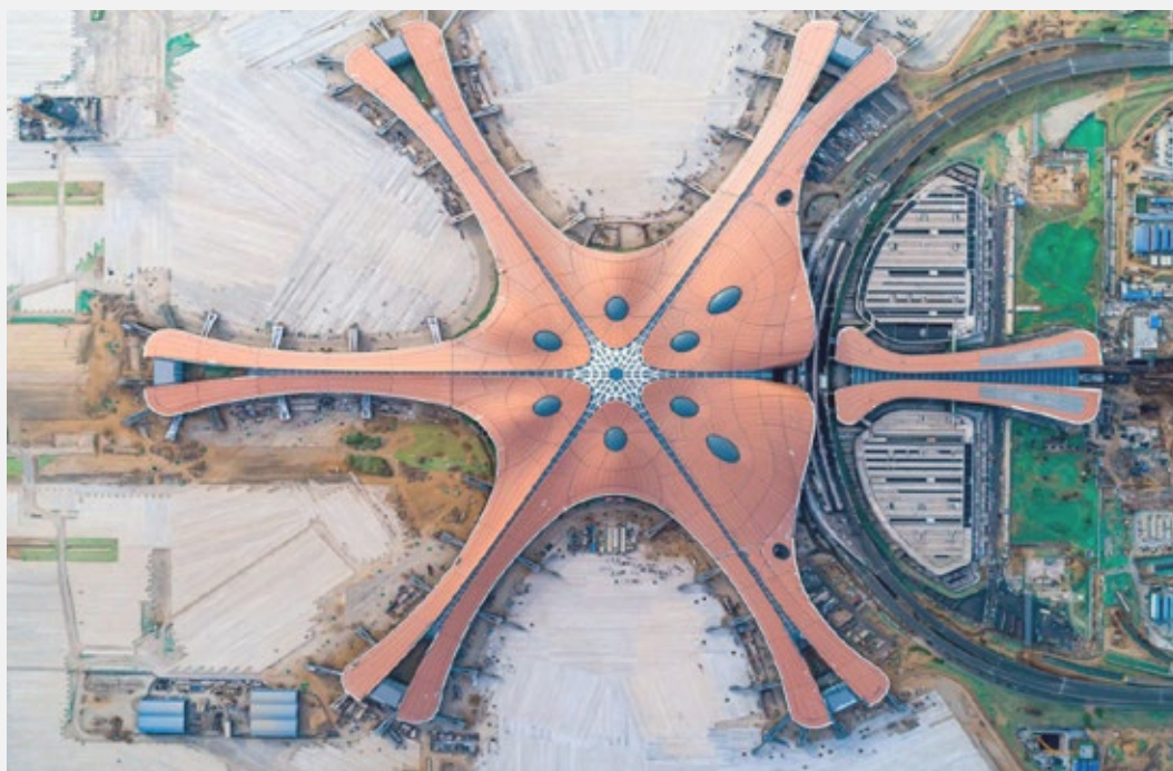
Figura 2.5.14: Immagine aerea del Daxing airport di Pechino, progettato dallo studio Zaha Hadid Architects e completato nel 2019. (Pintos, 2019a)
