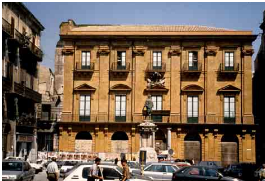
Fig. 15 Palermo, 'Palazzo Belmonte-Riso'. Façade facing 'Corso Vittorio Emanuele'
