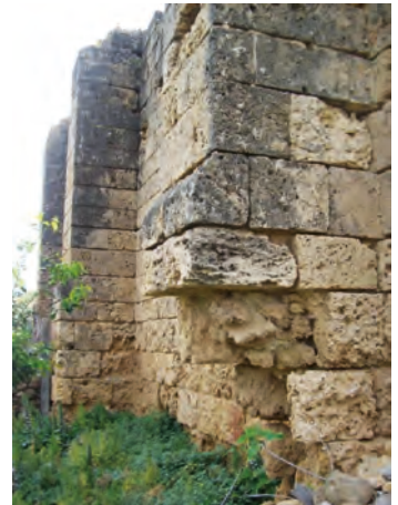
Fig. 14 Altavilla Milicia (Palermo), chiesa di Santa Maria di Campogrosso, nella zona di muro tra l'abside centrale e quella laterale è ricavata questa nicchia retta ad armadio, incorniciata da una sagoma sporgente e probabilmente simmetrica a quella che doveva trovarsi nell'altra abside (foto dell'autore, 2015)
