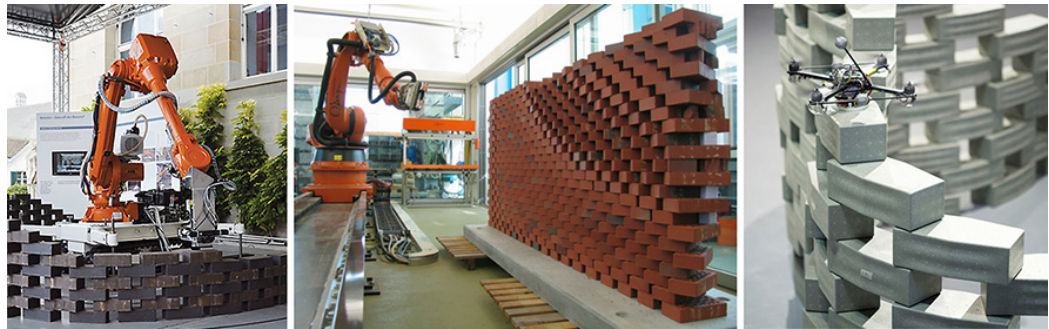
Fig. 6. Costruzione di paramenti murari con sistemi a braccio robotizzato (Gramazio e Kohler dell'ETH di Zürich) o con l'impiego di droni.
