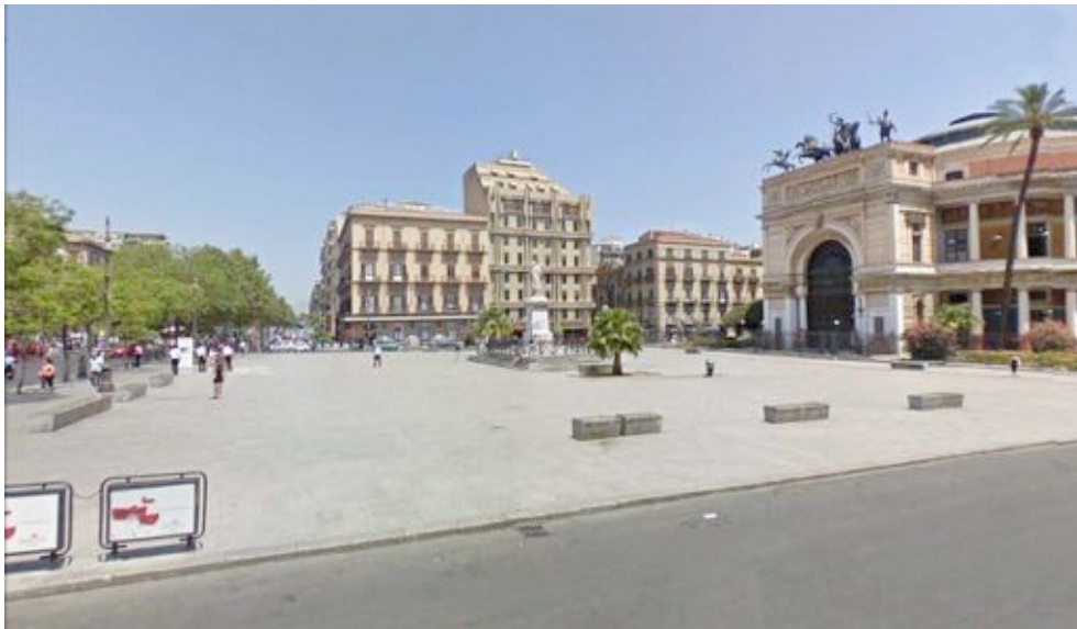
Fig. 5. La pavimentazione della zona antistante il teatro (Piazza Ruggero Settimo)
