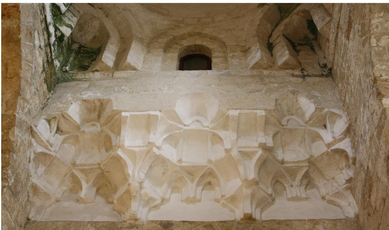
Fig. 11. Struttura a muqarnas della SS. Trinità. La struttura è composta da due moduli disposti in modo alternato (A+B+A+B+A). I moduli sono separati da elementi a L ortogonali e disposti a  $45^\circ$  rispetto alla parete di fondo.
