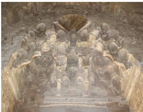
Figg. 9, 10. Struttura a muqarnas sita al primo livello della Zisa di Palermo. La struttura è composta: da due moduli angolari uguali e simmetrici rispetto al piano bisettore dell'angolo; da un modulo centrale identificato al primo livello da elementi a L ortogonali alla parete di fondo.
