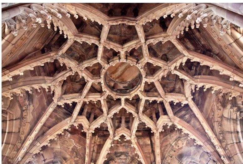
Fig. 3 Volta del campanile della cattedrale di Strasburgo
