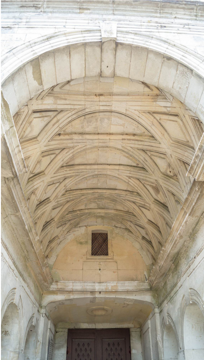
Fig. 34, château di Anet, volta del padiglione di ingresso di Philibert de l'Orme, da http://blog.agfg-franconville.fr/interieur-du-chateau-danet/
