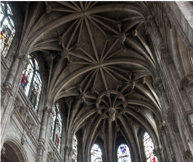
Fig. 19 Parigi, Saint-Eustache, dettaglio della chiave pendente (foto di G. Nuccio)
