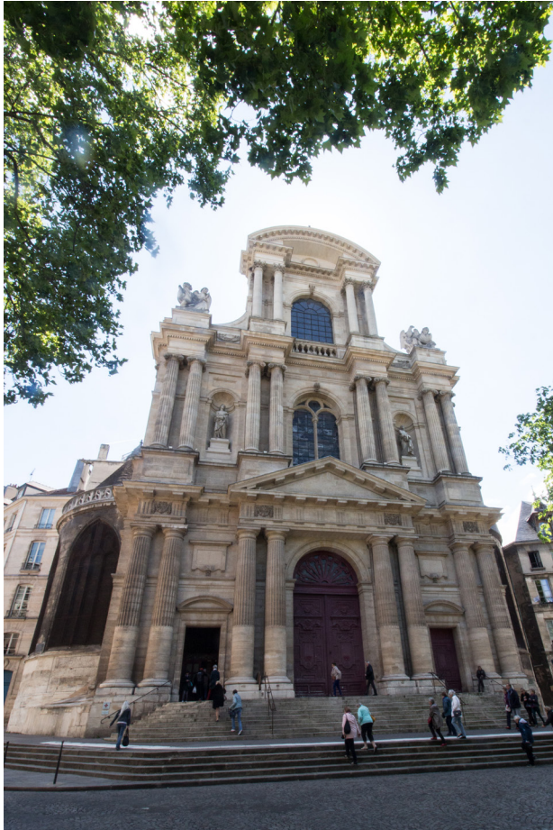
Fig. 1, Parigi, facciata della chiesa di Saint-Gervais (foto di G. Nuccio)
