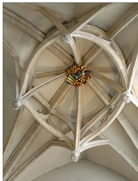
Fig. 20 Dettaglio della copertura della cappella del Crocifisso della chiesa di Saint Paul, Lyon
