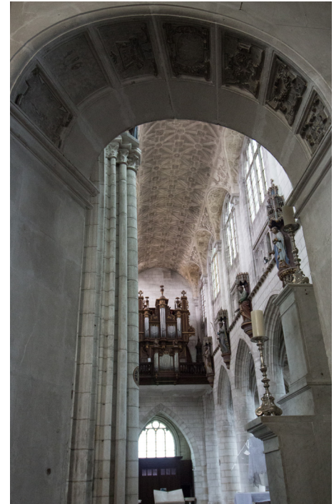
Fig. 41 Arco in esviaje , chiesa di Saint Jean, Auxerre (foto a cura di G. Nuccio)
