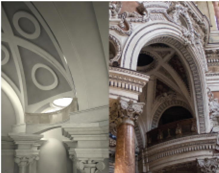
Fig. 48 Nell'ordine: terminazione della volta a crociera e balaustra della chiesa per i padri Somaschi di Guarini, vista del modello tridimensionale; Torino, chiesa di San Lorenzo, volta e tribuna di una delle cappelle diagonali (elaborazione grafica a cura di G. Nuccio), in S. Piazza, Guarino Guarini...op. cit. , p.74 fig.5
