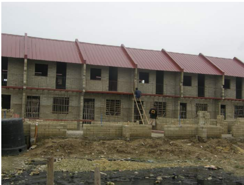
Figura 3 | L'accrescimento modulare e incrementale del nuovo sistema abitativo di progetto. Fonte: Homeless People's Federation Philippines.
