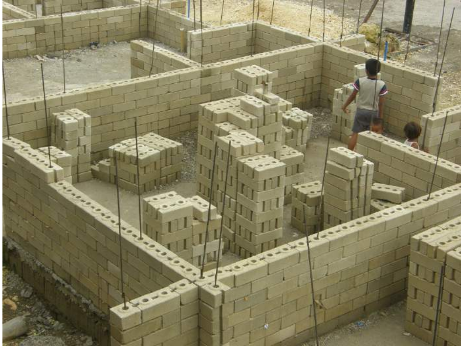
Figura 2 | Un momento del cantiere a Mandaue mediante l'utilizzo dei blocchi ICEB. Fonte: Homeless People's Federation Philippines.
