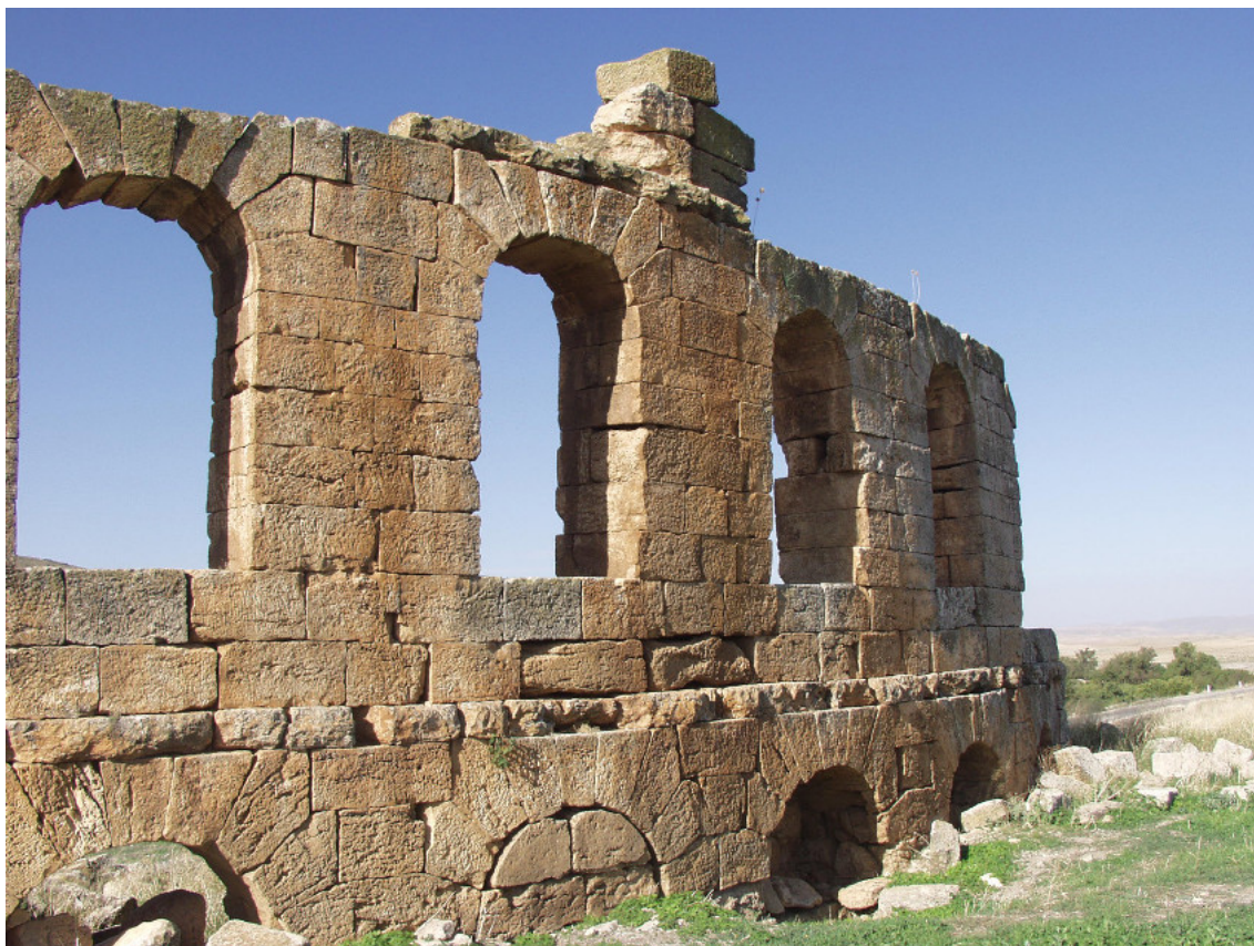
Fig. 27. Althiburos . Teatro. La parete esterna del muro perimetrale: dal terreno emergono parte del II ordine, il III ordine e scarsi resti dell'attico. Da Sud-Est (ottobre 2007).
