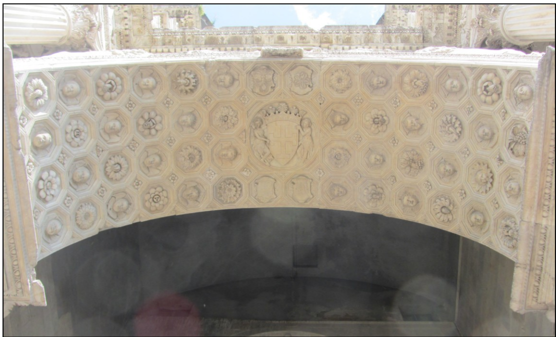
14. Particolare dell'intradosso dell'arco di Castelnuovo (Napoli)
