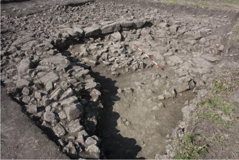
Fig. 14. Livelli di pietre (US 9 e US 12) relativi al crollo dell'edificio ED 02 forse riferibile ad una prima fase islamica (o tardo bizantina?).
