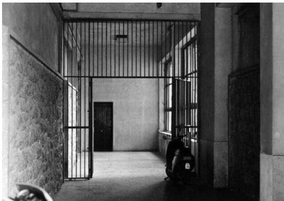
fig. 9 : le portillon d’accès à la salle N triangle
