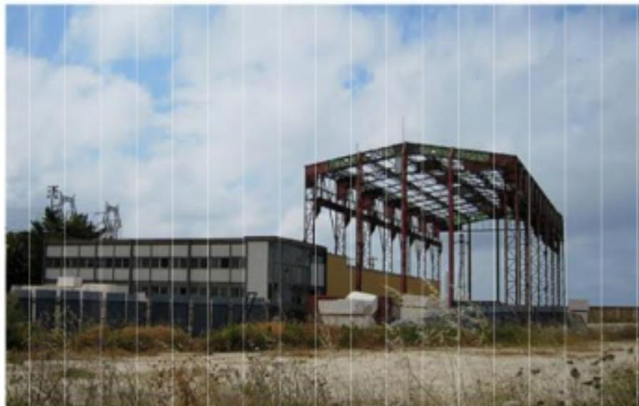
Giuseppe Samonà, *centrale di Trapani*, Trapani 1962. Elaborazione dell'Autore. Vista attuale della struttura della centrale. La sala macchine in acciaio si eleva di 16 metri sul suolo, in primo piano l'edificio degli uffici e il piccolo volume della scala.
