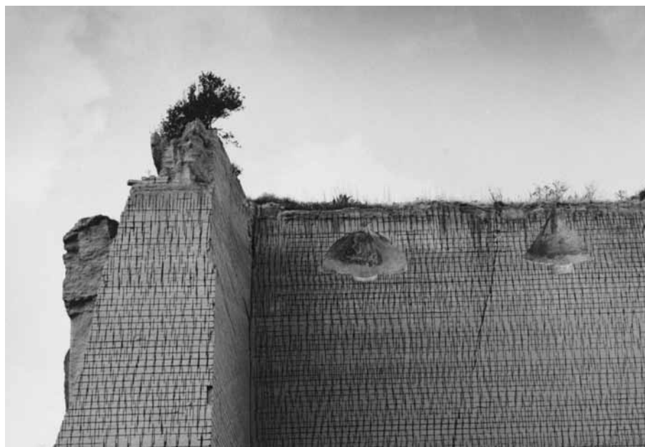
Parte sommitale della parete della cava all'interno del parco dell'Addolorata
