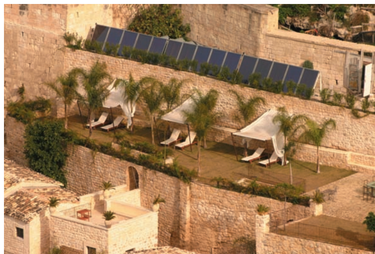
Sistemazione a verde sulle coperture alle pendici della rupe di San Matteo.
