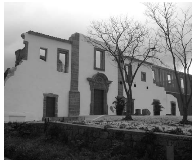
Salaparuta: restauro dell'ex Convento dei Cappuccini
