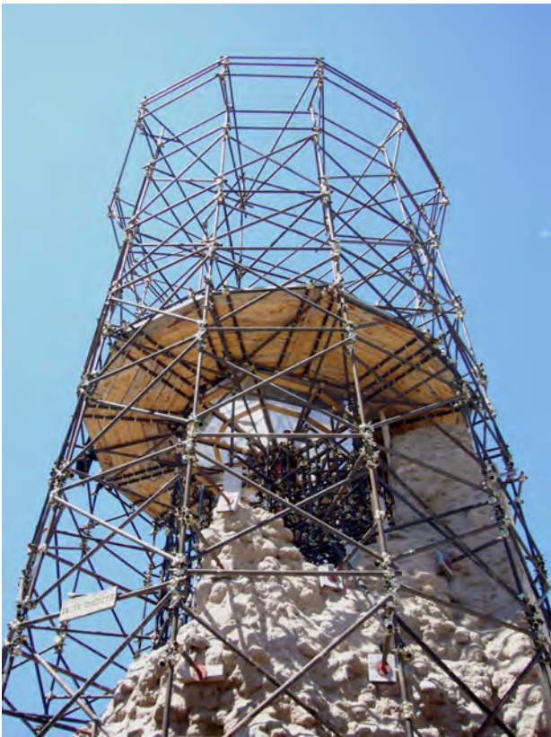
Fig. 8. La torre Medicea di S. Stefano in Sessanio sottoposta ad un intervento di messa in sicurezza con rimozione delle porzioni di muratura in pericolo di crollo a seguito del sisma aquilano del 2009. È stato realizzato un presidio di sicurezza che ripropone l'originale skyline della torre, 2012-2016 (< http://www.usrc.it/i-progetti-ed-i-cantieri-della-ricostruzione-pubblica/area-omogenea-4/ricostruzione-torre-medicea-s-stefano-di-sessanio-aq > [22/11/2106]).
