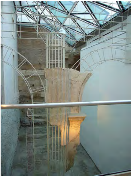
Fig. 7. Ricostruzione a fil di ferro degli archi del criptoportico nella Crypta Balbi a Roma su progetto di Franco Ceschi, 2000 (da GIZZI 2003).
