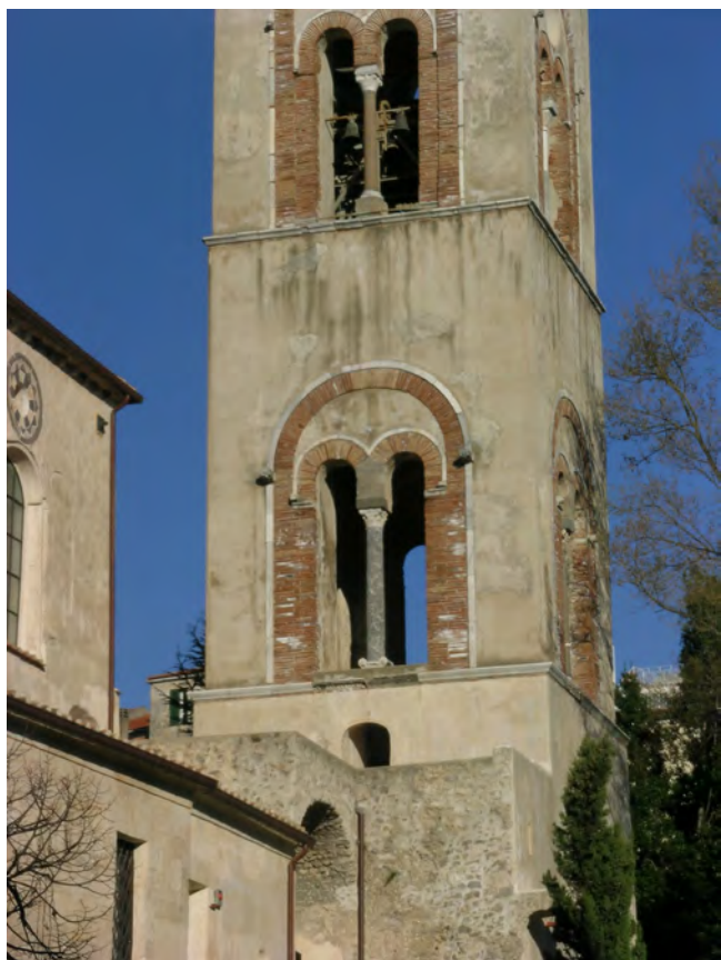
Fig. 7. Ravello, particolare del campanile del duomo. L'inserimento di elementi di spoglio, come il capitello alla base della colonna della bifora, pone un problema complesso per la modellazione parametrica propria degli strumenti generalmente impiegati nel campo dell'AEC ( architecture, engineering, construction ), in quanto la natura intrinseca dell'elemento non corrisponde necessariamente a quella assunta nella fabbrica.
