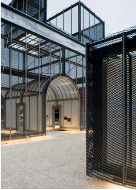
Fig. 5. Ricostruzione delle linee essenziali della Porta Praetoria di Windisch con profili e superfici metalliche, progetto di P. Liechtl, L. Zumsteg e A. Graf, 2007 (foto E. Petrucci).
