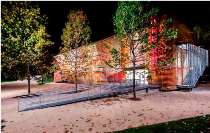
Immagini dell'Auditorium dell'Aquila e schizzo di progetto, Renzo Piano Building Workshop, L'Aquila, 2012
