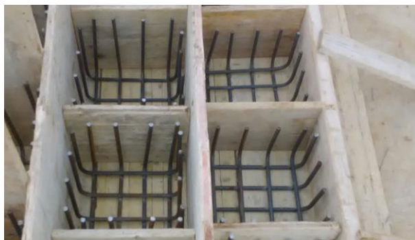
Figura 4.1 – Preparazione delle casseforme e disposizione delle armature.
