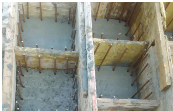
Figura 4.2 – Getto del calcestruzzo all'interno delle casseforme.
