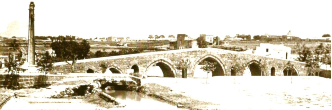
Fig. 6 Negli ultimi decenni del secolo XIX il ponticello si presentava in condizioni di degrado e, probabilmente, leggermente allargato
