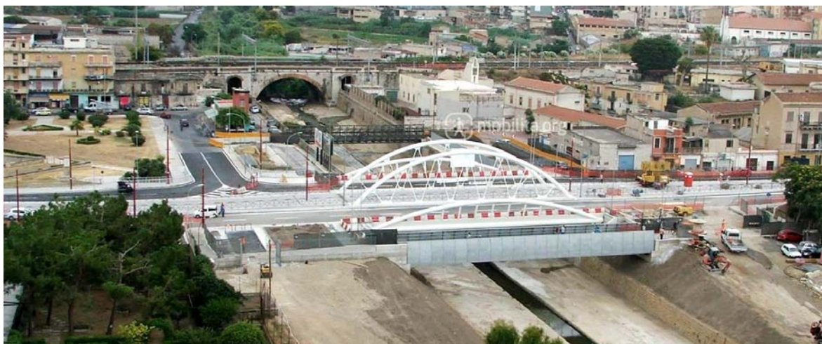
Fig. 29 Il nuovo ponte bimodale in acciaio (quarto ponte delle Teste)
